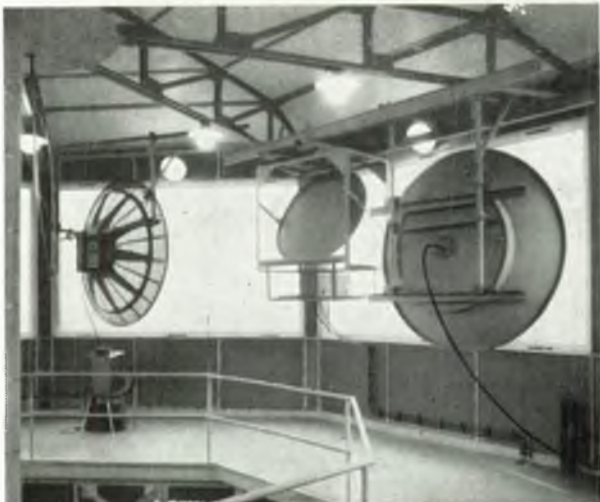
De parabolische antennes van de straalverbindingen met Brussel, op het Torengedouw te Antwerpen
